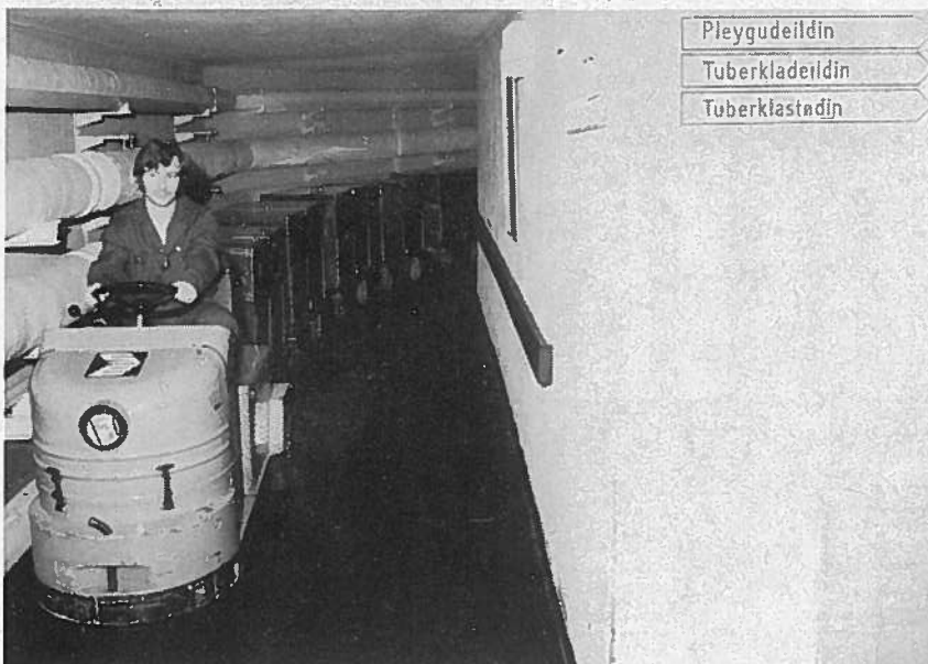
Statshospitalet. Tunnel. Madvognstog.
